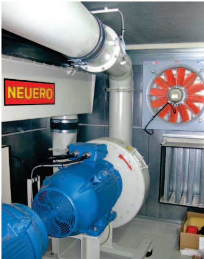
Direktantrieb und NEUERO-Schalldämpfer | Bild: NEUERO Industrietechnik
