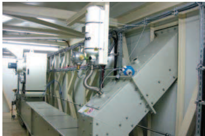
Ex-Schutz-Löschmittelbehälter und Entstaubungsfilter
